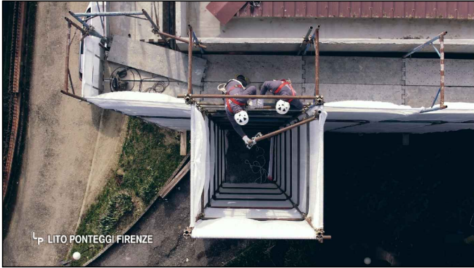
PIANO DI CARICO PER TIRO IN QUOTA MATERIALE
